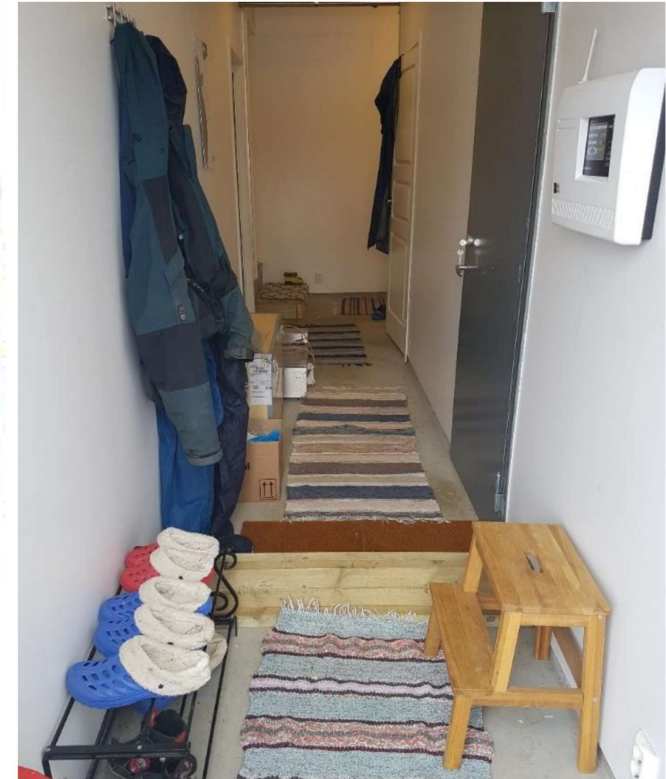
Bilde 9 Smittesluse med mulighet for å skifte sko og klær, kl og et opphøyd skille mellom sonene.
