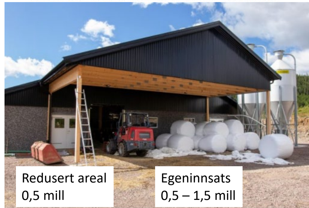
Fôrsentralen er bygd på utsida av fjøset ved at taket er strukket ut. Det foreligger planer om å kle veggene for å hindre at snøen føyker inn. Utfôringa skjer per nå med kompaktlaster. Foto: Morten Livenengen
